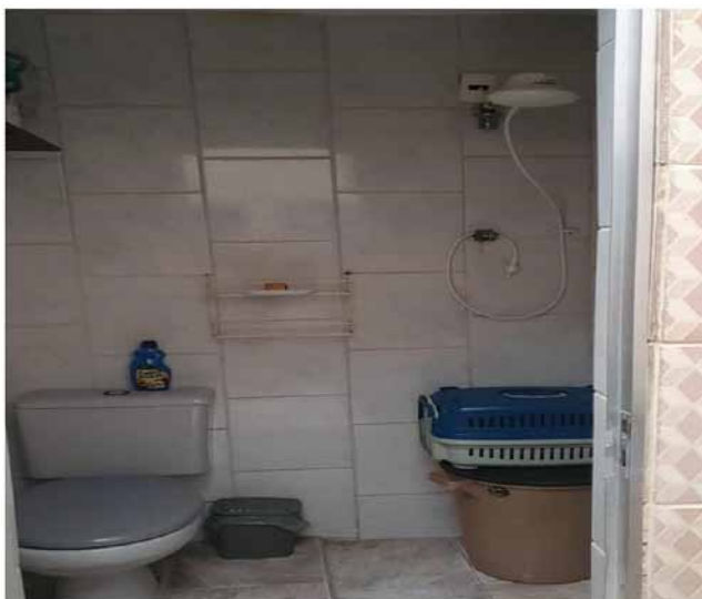
Fig. 8. Maid's Bathroom and Storage – Piedade – Rio de Janeiro – 2023.
