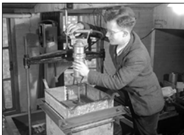
Fig. 1. T. K. Chaplin compacting dry sand
