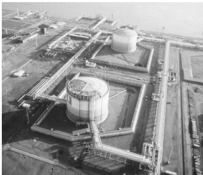
Fig. 2 LNG tank Pyong Taeg, Korea
